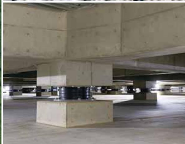
先進のロボットによる生産により、材料の入れ間違い等の人為的なミスを削減、人の手作業によって起こる菌の付着や異物混入の可能性を削減します。また、新工場の建屋は免震構造が採用されており、震度7の地震にも耐えられる想定です。免震構造では、地下に設置された免震装置によって、地震の揺れが建屋に伝わりにくくなっております。これによ
