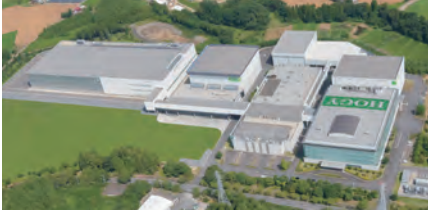
筑波新キット工場
