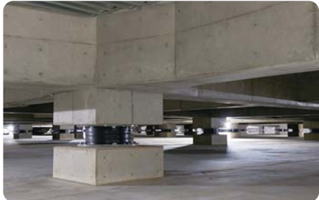
新工場の免震構造
